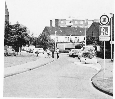
Abb. 53: Fahrbahnverengung zur Herabsetzung der Geschwindigkeit in einem Wohngebiet in Münster [12]
